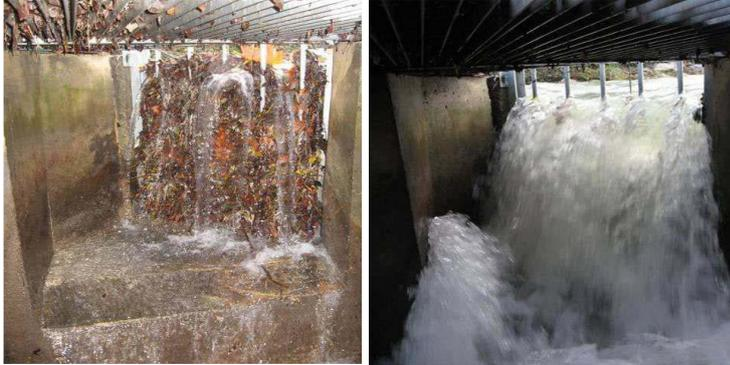
**Figure 20 : Comparaison de la passe à poissons du pont de Serbie. A gauche la passe non entretenue et à droite la passe entretenue. (Source : CISALB, 2013)**
