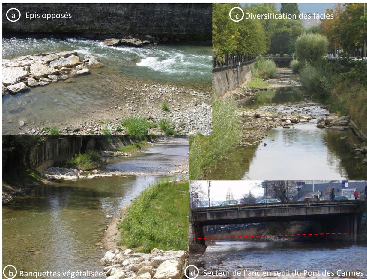
**Figure 16 : Photographies des aménagements sur la Leysse (a) avec des épis opposés, (b) des banquettes végétalisées, (c) la diversification des faciès et (d) l'ancien seuil du Pont des Carmes. (Photos : CISALB)**
