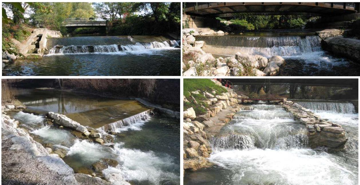
***Figure 26 : Comparaison photographique avant/après les travaux du Sierroz (en haut 2007 et en bas 2014). A gauche le seuil du Pont Garibaldi et à droite le seuil du Pont SNCF. (Source : CISALB, 2007 et FSPPM, 2014)***
