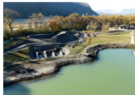
Fondations des quais de la grange batelière
